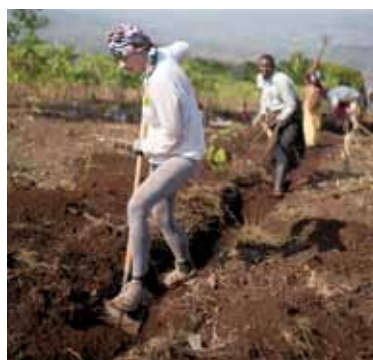
Der Bau der Wasserleitung unter sengender Sonne.
