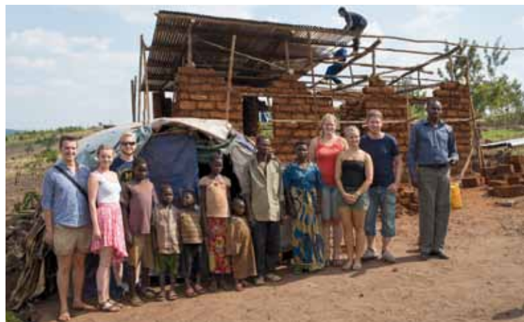
Vor einer notdürftigen Zeltunterkunft. Im Hintergrund das neue Haus im Entstehen.
